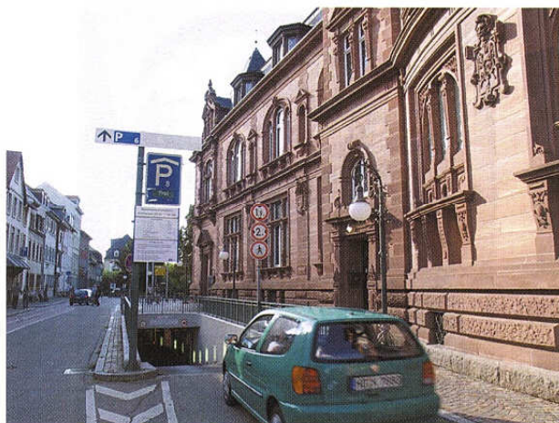
図5 地下駐車場入り口
