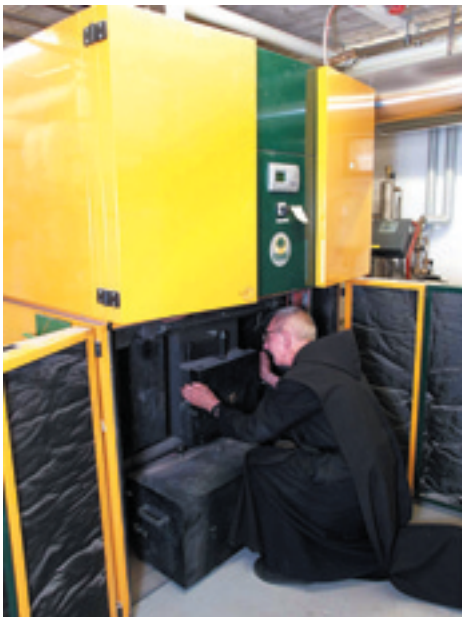
図15 木材チップを燃料とする新型ボイラー（KWB社製）
