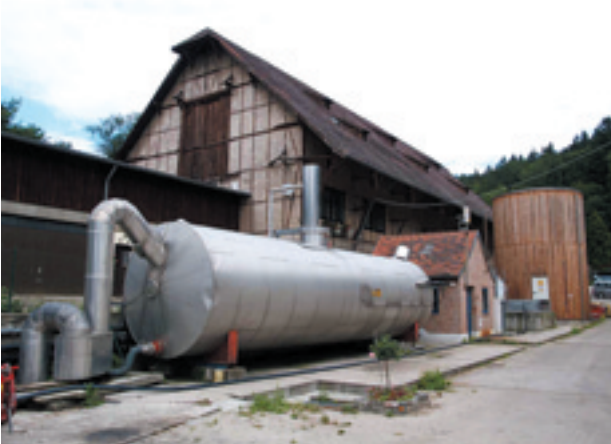
図13 コージェネレーション設備
