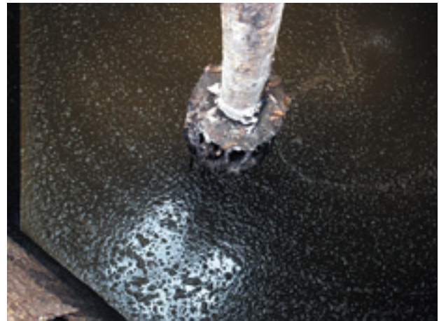
図14 糞尿の一時貯蔵タンク
