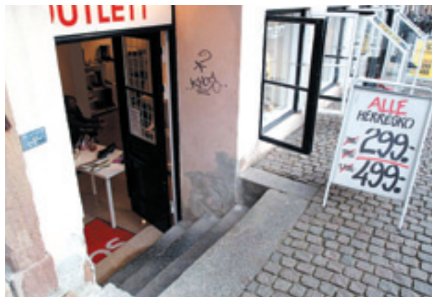
写真2 “半地下階”の入り口
